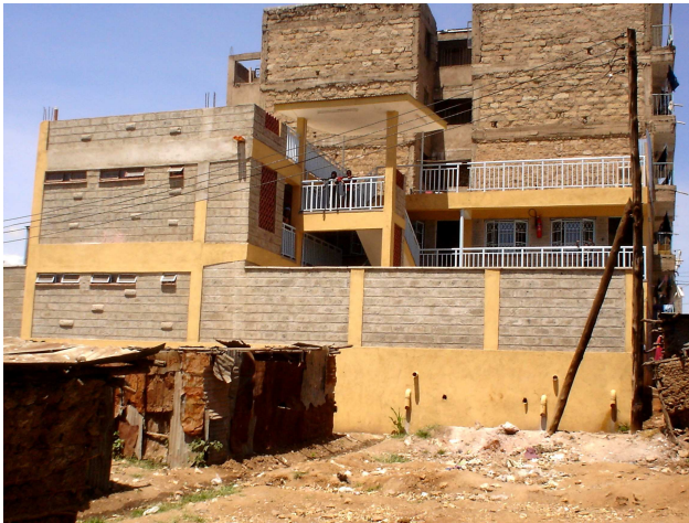
Center nach Abschluss der 1. Bauphase 2004
